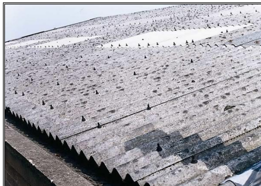
Rysunek 1. Dach pokryty azbestową płytą falistą
